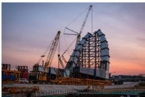
La complexité de l'ouvrage vient de son **asymétrie** : les deux arches ne sont pas parallèles. Les fondations ont dû être alignées sur le cours de la rivière, pour en respecter les courants et éviter d'endommager l'empierrement des berges, réalisé 1000 ans plus tôt pour protéger la capitale. Les 30m d'alluvions sur lesquels la capitale repose, témoignent du parcours erratique de la fleuve sur le bassin pékinois, et de méandres qui n'ont cessé de changer au cours des millénaires.
