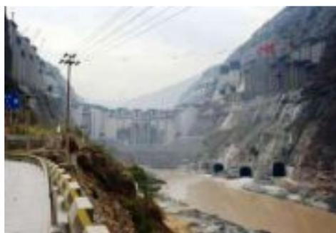
Aux confins du Tibet et du Sichuan, le groupe **Huadian** entame la construction d'un barrage hydroélectrique à **Suwalong**, le premier sur la **Jinsha**, le cours supérieur du Yangtzé. Le coût dépassera les 3 milliards de \$, et le tablier les 112 mètres de hauteur. Le réservoir contiendra ses 674 millions de m<sup>3</sup>, et la capacité de production fera 1,2 GW (*plus puissant qu'un réacteur nucléaire conventionnel*), à partir de 4 turbines.
