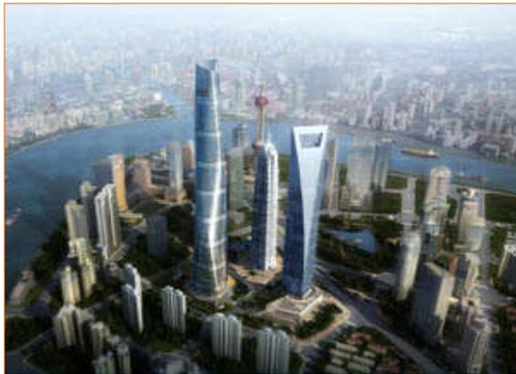
Remède anti-crise : la « *Shanghai Tower* » (chantier lancé le 29/11), 121 étages, 632m, 2,2MM\$, forme torique contre les vents, 54 turbines à vent pour produire son énergie.
